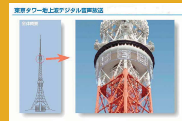
(上) 東京タワーの「特別展望台」(地上約250m)に設けられた送信設備。(右) デジタルラジオ専用受信機 (試作機)。
